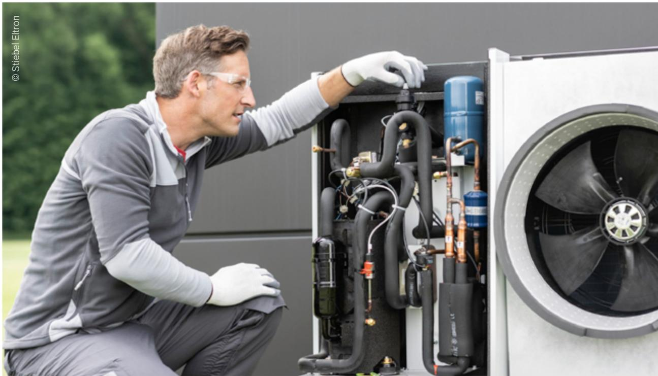
Häufig wird dem Regelgerät der Wärmepumpe ab Werk ein Inbetriebnahmeprogramm vorgegeben, das einen sofortigen Regelbetrieb der Wärmepumpe verhindert. Dieser Programmablauf sollte unbedingt eingehalten werden, um die Reglereinstellungen und die einzelnen Funktionsprüfungen ordnungsgemäß durchführen zu können, bevor der Kältekreis in Betrieb geht.
